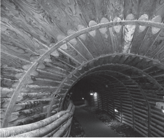
模擬坑道，今は新しい木材で安全に再生されている
