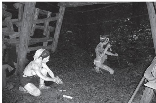
③昭和中期には坑道が大型化した。搬出作業に炭車(石炭を積む手押しトロッコ)が導入され、鉋夫の賃金は積み具合によって変動した(1940年代)
